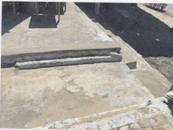
**Observações:** Calha de drenagem no calçadão existente para encaminhamento das águas pluviais.
