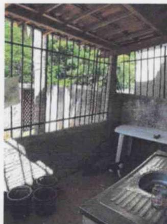
Área de serviço em desuso por conta do seu estado inadequado. Paredes incompletas, sem reboco e pintura, piso sem revestimento.
