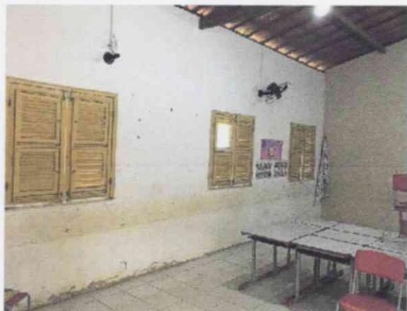
Sala de aula sem forro, facilitando o acúmulo de sujeira e esquadrias com desgaste na pintura.
