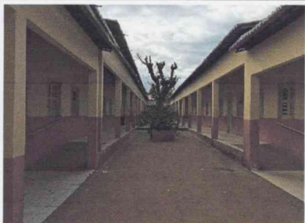
Desgaste na pintura da edificação e parte da cobertura encontra-se danificada.
